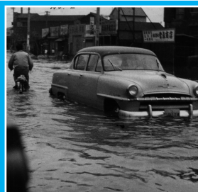
昭和33年 狩野川台風 京葉道路・小松川3丁目付近
